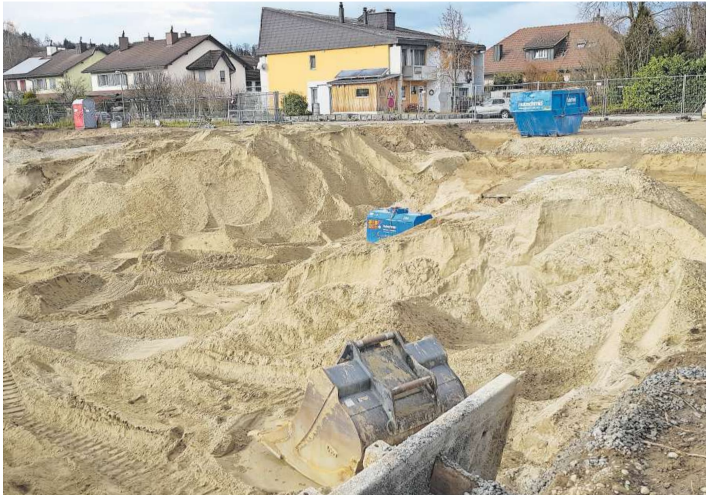
Versiegelt unter einer Lehmschicht kam beim Aushub in Rottenschwil feinsten Sand zum Vorschein.
