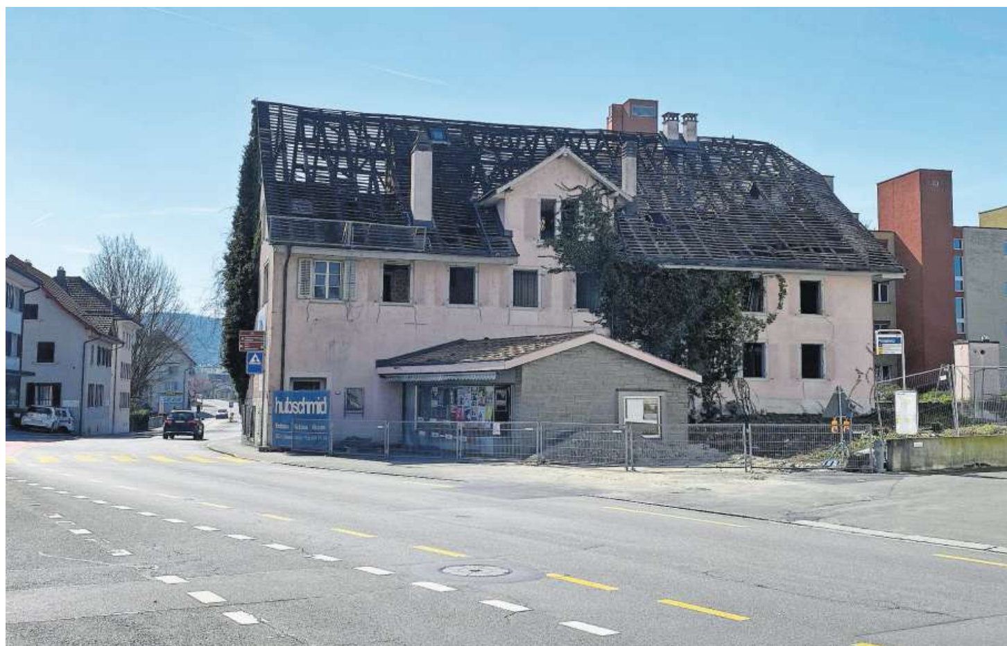
Durchsichtiges Dach: Beim ehemaligen Geschäftshaus der Bäckerei Kuhn in Wohlen sind alle Dachziegel entfernt.
