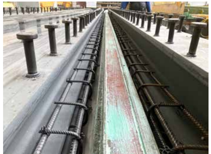
Die Träger liegen in der Schalung mit Armierungseisen. Nun kann der Beton angebracht werden, die sogenannten Kragen entstehen.
