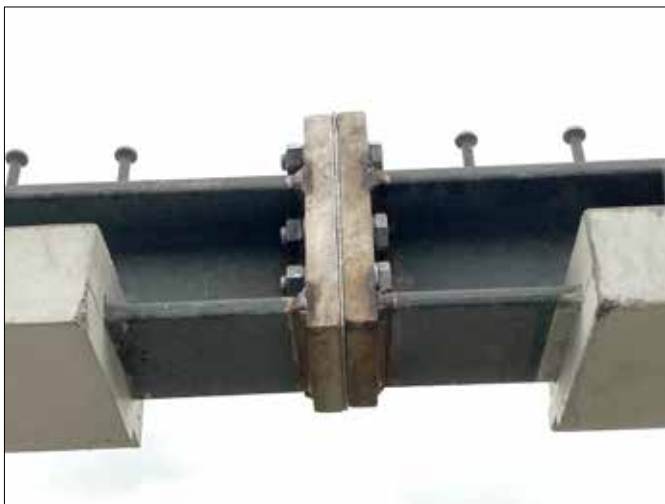
Nach der Verschraubung auf der Baustelle wird der noch fehlende Beton ergänzt und das ganze gestrichen.
