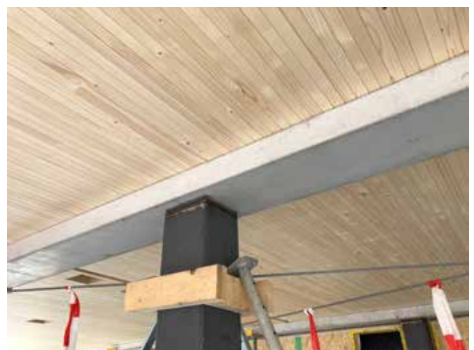
Der Stahlträger ist mit einem Betonkragen umhüllt. Die Untersicht bleibt als Holzdecke sichtbar.
