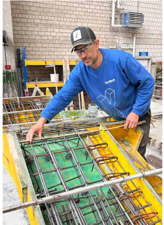
Nach dem Armieren wird die Treppe kontrolliert.
