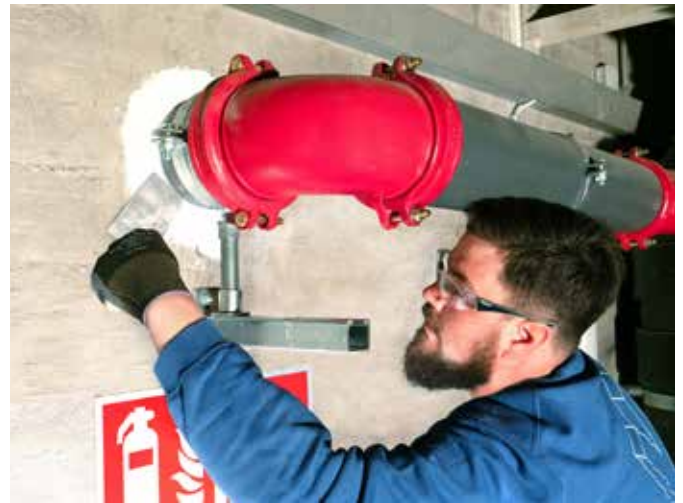
Brandschutzverarbeiter Joel Wey bringt eine Abschottung an.
