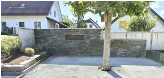
Gartensitzplatz mit einem Sichtschutz aus Luserna Classico Steinen.
