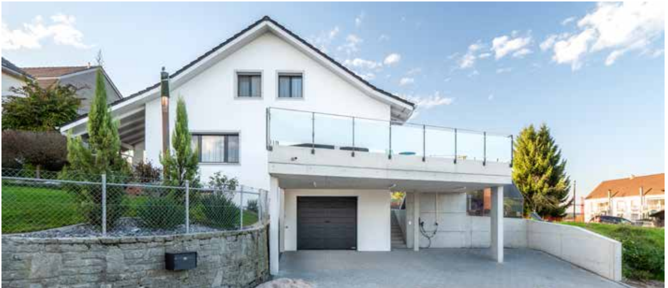
Bei diesem Einfamilienhaus durften wir einen Carport und Umgebungsmauern erstellen sowie die Fassaden sanieren. Das Gartenbauteam gestaltete den Aussenbereich inklusive Lounge- und Grillplatz neu. Bild: Marco Matter
