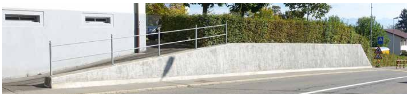
Für den Deckputz dieser alten Schwergewichtsmauer wurde eine Mischung nach Grossmutterart verwendet.
