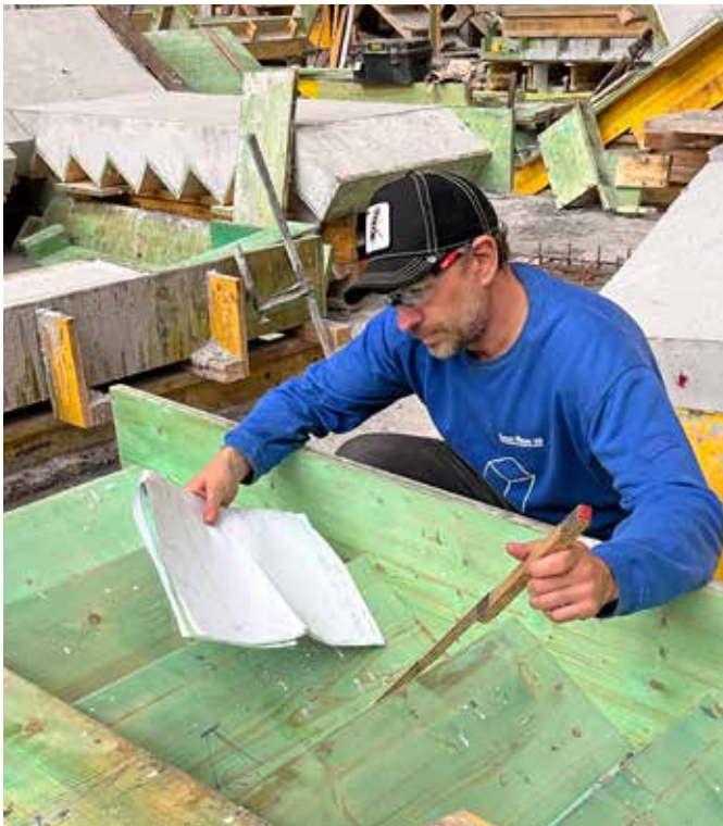
Rene Graf kontrolliert das Treppenmass vor dem Armieren.
