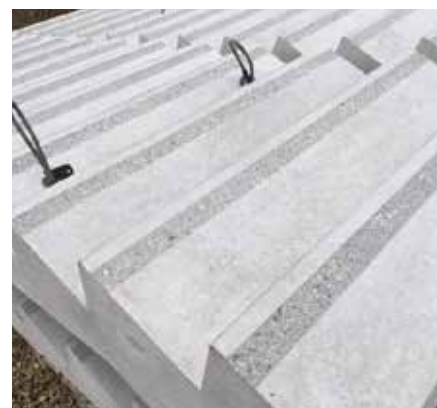
Mit drei Rillen (links) oder den 5 cm breiten gestrahlten Streifen (rechts) werden die Auftritte der Treppen rutschticher. Kleine Branchenkunde: Der Treppen-Auftritt ist der Bereich, auf den man drauftritt. An der Setz- oder Stossstufe schlägt man die Zehen an. Treppenstufe umfasst das ganze Element.
