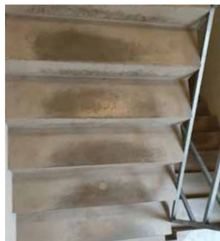
Im Vergleich: links eine Treppe mit Lasur, rechts ohne Lasur. Gut sichtbar sind hier die Gehspuren und die speckig glänzende Oberfläche.
