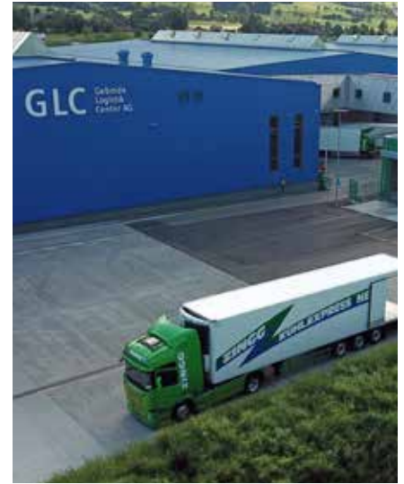
2005/06 liess die Zingg-Gruppe durch die XMAG das Gebinde Logistik Center im Villmerger Industriegebiet bauen. Die grosse LKW-Flotte ist Werner Zinggs ganzer Stolz. Bilder: zVg
