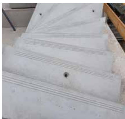
Mit drei Rillen (links) oder den 5 cm breiten gestrahlten Streifen (rechts) werden die Auftritte der Treppen rutschticher. Kleine Branchenkunde: Der Treppen-Auftritt ist der Bereich, auf den man drauftritt. An der Setz- oder Stossstufe schlägt man die Zehen an. Treppenstufe umfasst das ganze Element.
