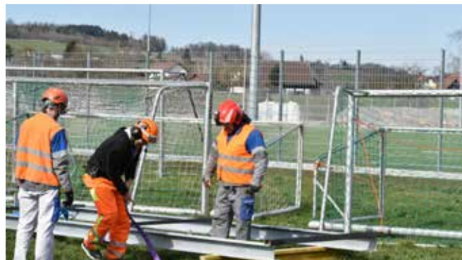
Die Gurten für den Lufttransport werden angebracht.
