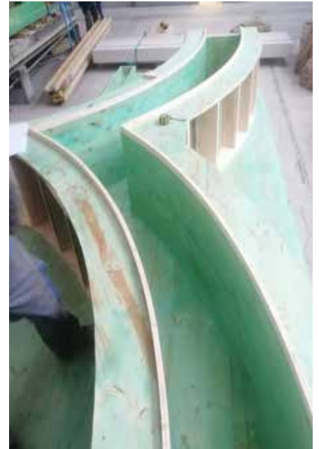
Die Schalung wurde mittels CNC-Maschine zugeschnitten.
