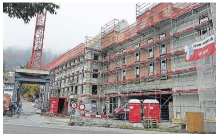
Die Ex-«Rössli»-Fassade (links) ist in den Neubau integriert. Bild: zvg
